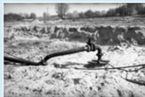
Grundwasserabsenkung
