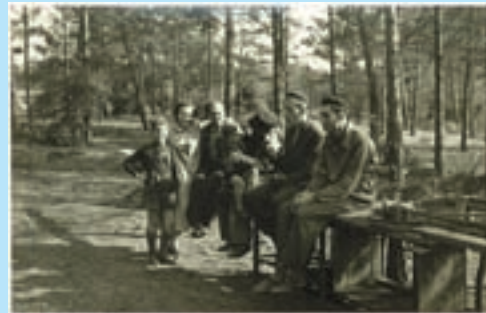
Im Walzwerk werden Sonderschichten gefahren, um die benötigten Eisenteile herzustellen. Auf der selbst gebauten Eisenbiegebank, die hier einer kurzen Rast dient, werden die Moniereisen gebogen.
