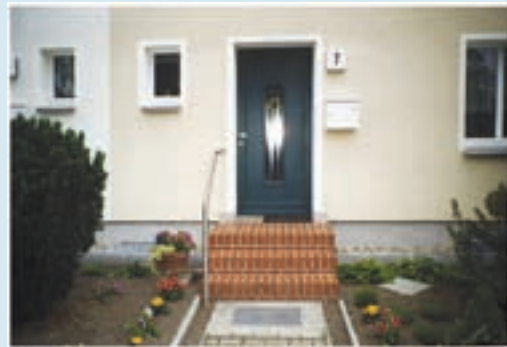
Hauseingänge vor und nach der Erneuerung
