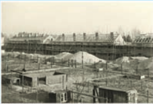
Im Mai 1959 werden die ersten Wohnungen des vierten Bauabschnittes übergeben.
