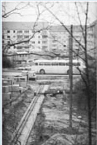
Vorbereitung zur Grundwasserabsenkung
