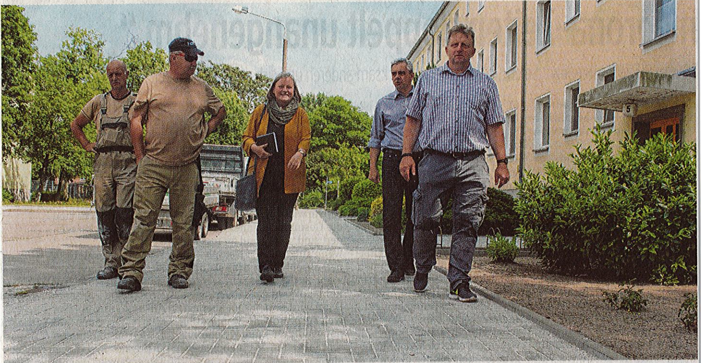
Neuer Gehweg für den Finkenweg: Die Mitarbeiter der ausführenden Firma F&N Bauausführungen bei der Bauabnahme durch Christiane Hoffmann in Begleitung von BGK-Chef Alf Seeber und Kirchmöser's Ortsvorsteher Carsten Eichmüller (v.l.n.r.).
